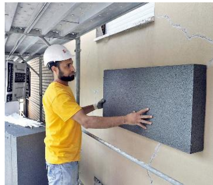
Una foto generica che rappresenta un intervento per l'efficiamento energetico in una abitazione
